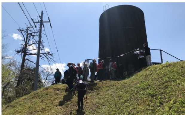
写真-3 サージタンク
