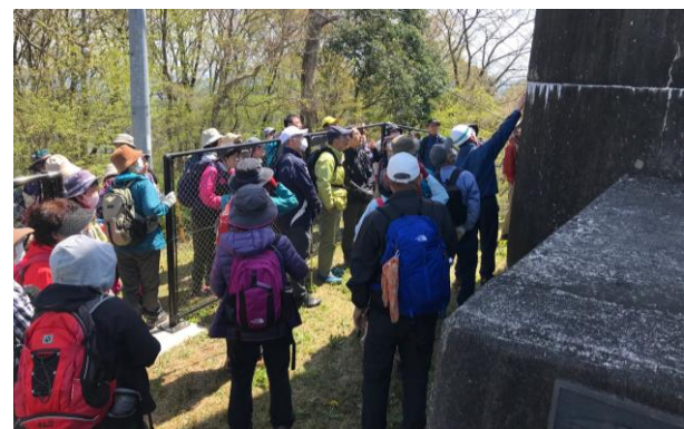
写真-4 サージタンク説明
