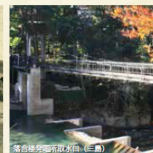
落合楼発電所取水口（三島）
