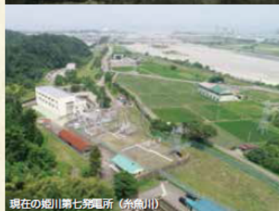
現在の姫川第七発電所（糸魚川）
